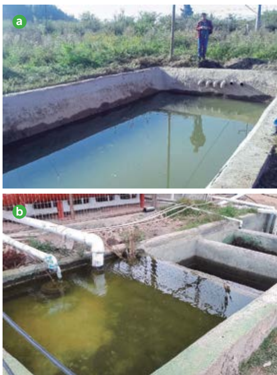
Figura 3. (a) Tranque de acumulación con aguas de alto contenido de sedimentos y (b) Sistema de decantación de aguas en etapa de prefiltro.
