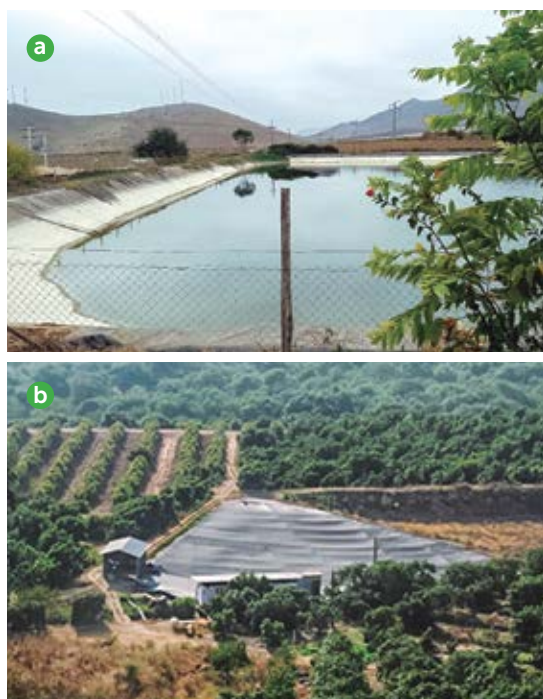
Figura 4. (a) Tranque acumulador de aguas (revestido y abierto), Limarí, Chile y (b) Vista de predio con acumulador cubierto con malla sombreadera, Región de Valparaíso, Chile.
