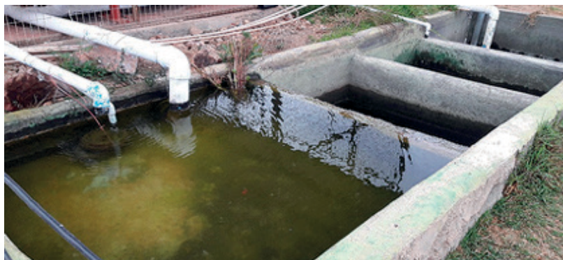
Fotografía 3. Sistema de decantación de aguas en etapa de prefiltro.
