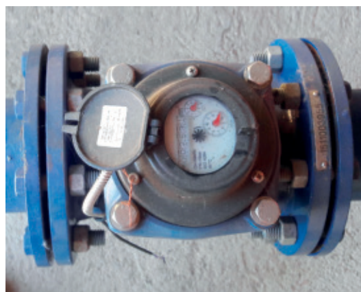
Fotografía 9. Uso de caudalímetro a salida de caseta de riego para registro del gasto exacto en cada evento de riego.
