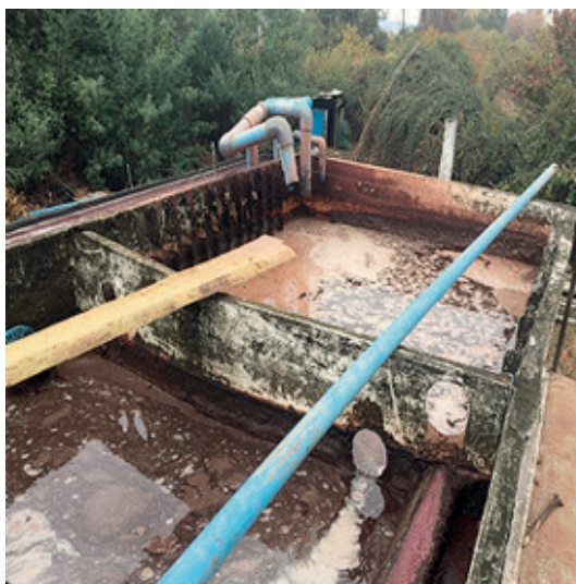
Fotografía 17. Planta de tratamiento de riles de un viñedo y reutilización de sobrenadantes para riego.
