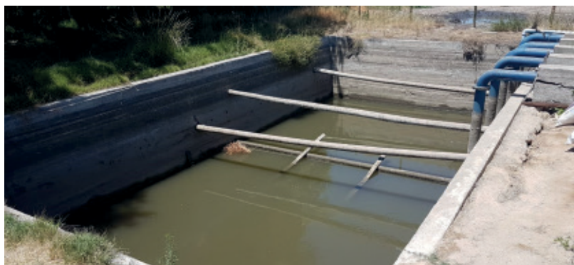
Fotografía 2. Tranque de acumulación con aguas de alto contenido de sedimentos.
