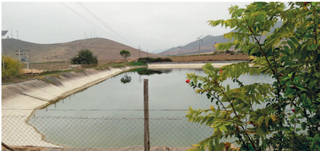
Fotografía 4. Tranque acumulador de aguas intrapredial (revestido con geomembrana, abierto y protegido)
