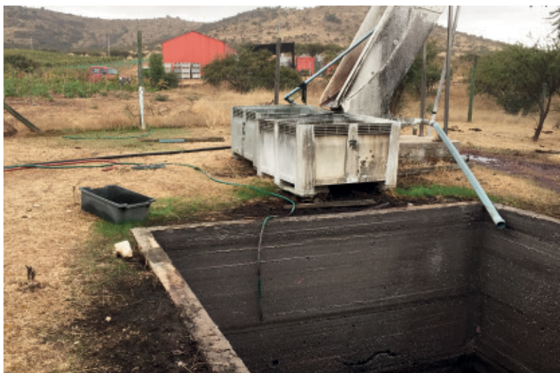
Fotografía 19. Uso de filtro parabólico previo a la piscina de agitación y neutralización del pH, los subproductos se depositan en los bins para pasar a proceso de compostaje.
