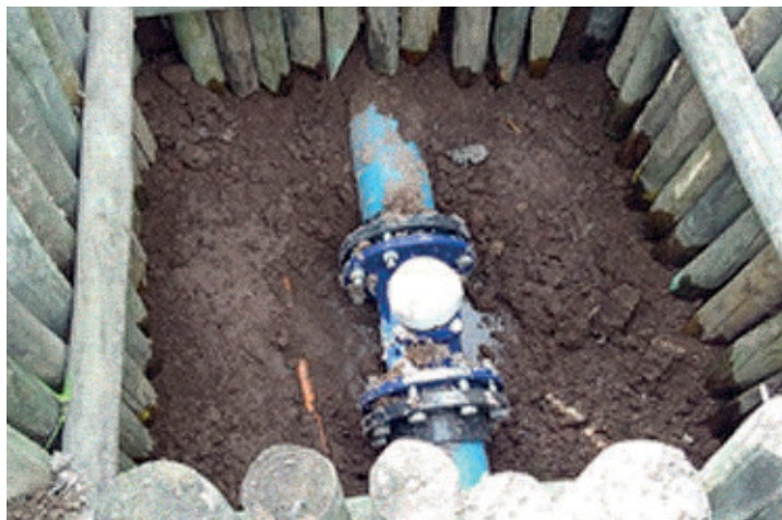
Fotografía 10. Ejemplo de caudalímetro instalado en un sector estudio para cuantificar huella azul en predio.
